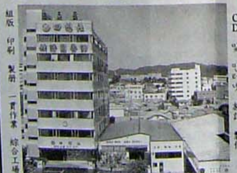
本社 社屋 全景
